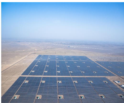
大型地面电站
