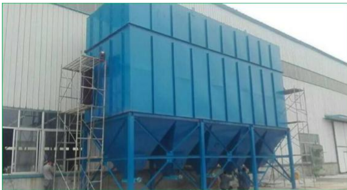
图 7.2-3 除尘器应用实例图
